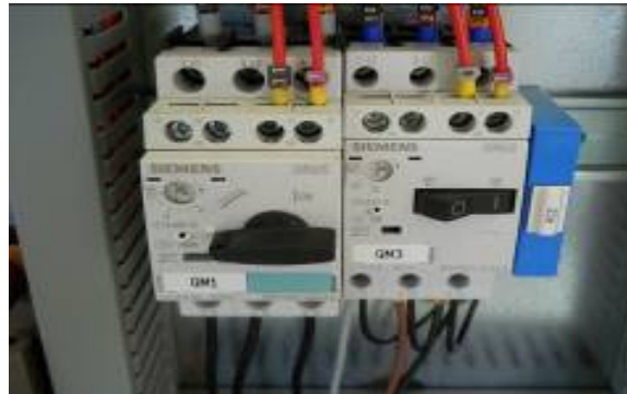
Figura 15 – Interruttore della pompa su ON
