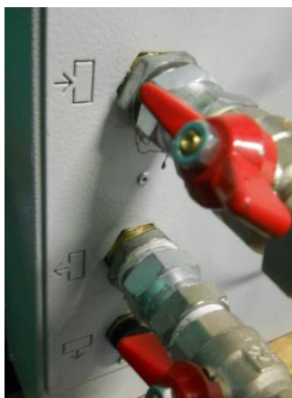
Figura 12 – Collegamento dei tubi
