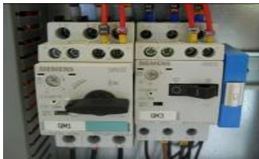
Abbildung 8 – Trennschalter OFF
